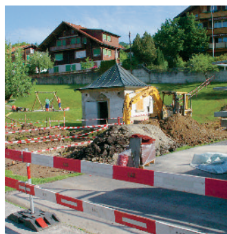
Wassermattli 1: Der neue Ökihof nimmt langsam Form an.
