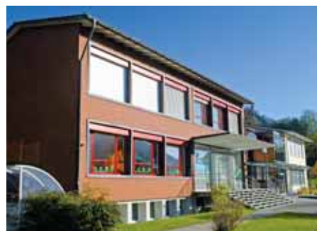
Schulhaus Morgarten: wird gemäss Minergiestandard saniert.
